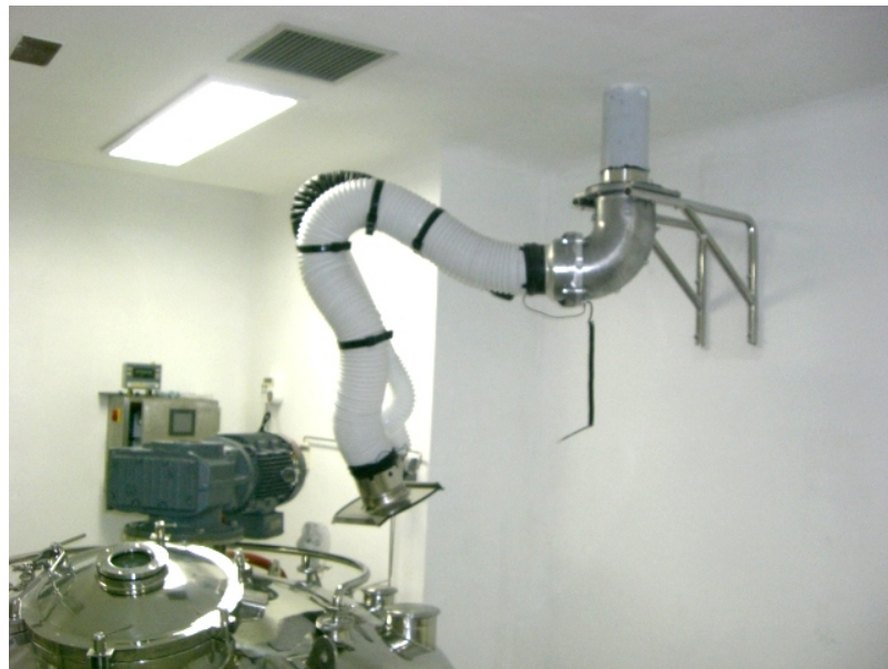
BRAÇO EXTRATOR HIGIÊNICO MODELO "NEX D" COM TUBULAÇÃO EM AÇO INOXIDÁVEL
